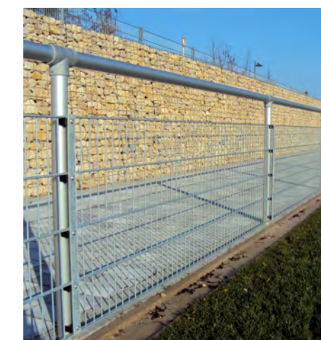
Barrieren mit Doppelstabfüllung
